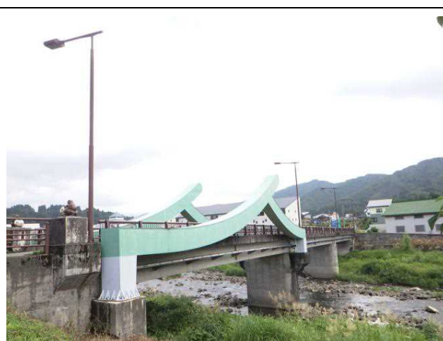
写真全景（コンクリート橋） （かえる橋）
